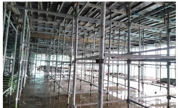
Khu vực thi công tầng 2, 3
