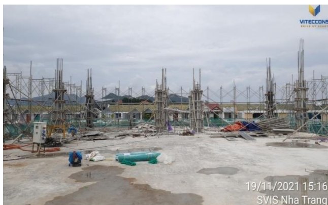
Đổ bê tông tầng 4
