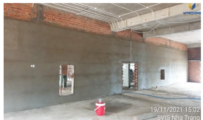
Thi công tường tầng 1
